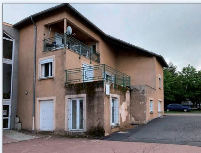
L'extension de la maison LAURENT comporte 4 logements, locaux du kiné et des infirmières. Ce bâtiment est une vrai passoire énergétique. Les travaux vont consister à refaire les façades avec une isolation, reprendre des toitures et remplacer le chauffage au gaz par une chaudière à bois granulé.
